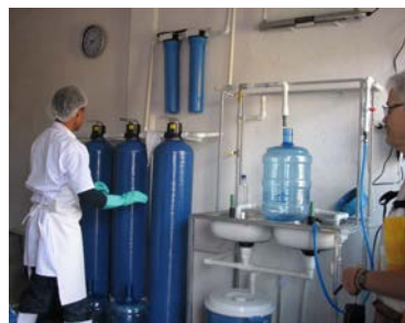
Système de purification d'eau embouteillée pour la coopérative d'embouteillage
